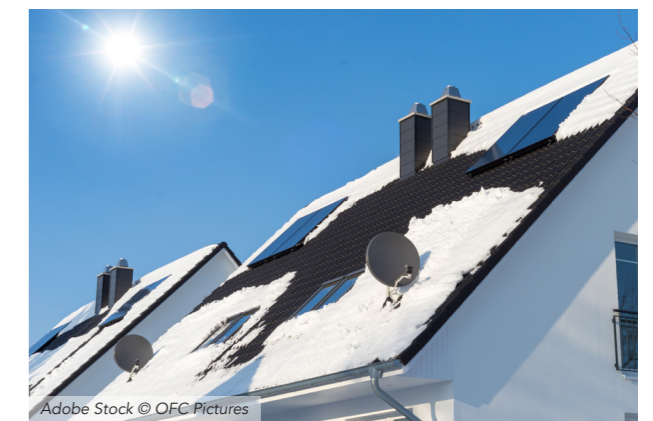
Wärmeverluste des Daches werden oft durch abschmelzenden Schnee sichtbar.
